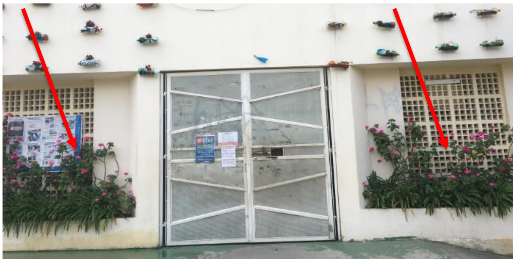
Vista Interna do local a ser executada a alvenaria de tijolo vazado
