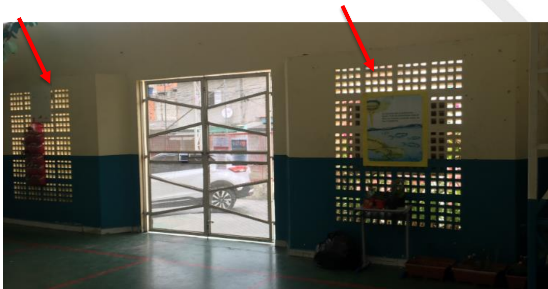
Vista Interna do detalhe da parede a ser demolido
