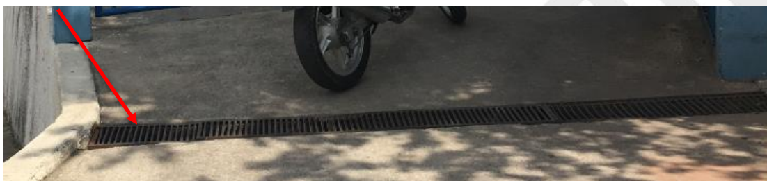
Grelha a ser removida e trocada
