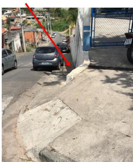
Imagem do local a ser demolido
